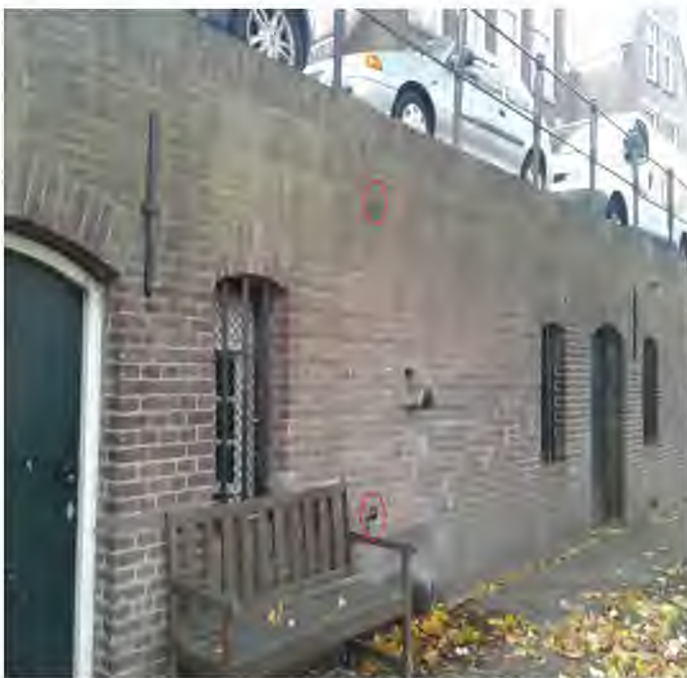
Figuur 3.2; Voorbeeldfoto positie prisma's (rood omcirkeld)
